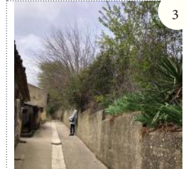
3 La rue du Castellat La rue du Castellat est actuellement une impasse piétonne partiellement empiétée par les riverains. L'impasse est longée par un mur de soutènement d'1,5 mètre de haut
