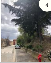
4 La RD33 est longée par un talus variant entre 2 et 6 mètres de hauteur et quelques places de stationnement
